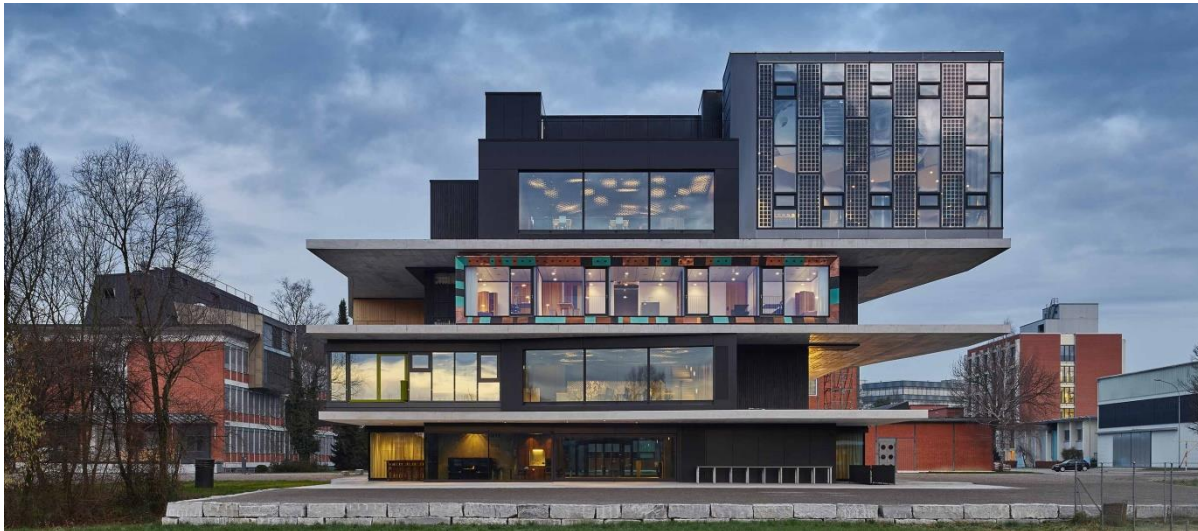
EMPA Forschungsgebäude NEST, Dübendorf
