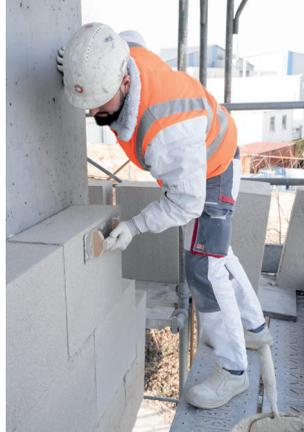
Zirkuläre Dämmstoffe mit Schweizer Rohstoffen aus dem Rückbau (Max Schweizer AG und swisspor AG)
